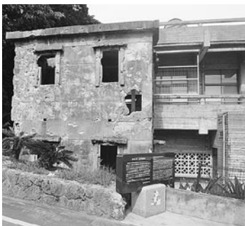
▲伊江島に唯一残る戦跡、公益質屋跡。海に面した南側には艦砲射撃による大きな穴が開いていた。 H30.6.22
